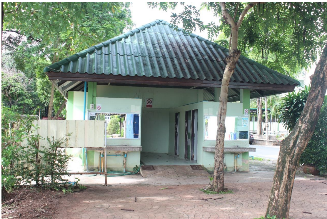
ห้องน้ำ-ห้องส้วม
