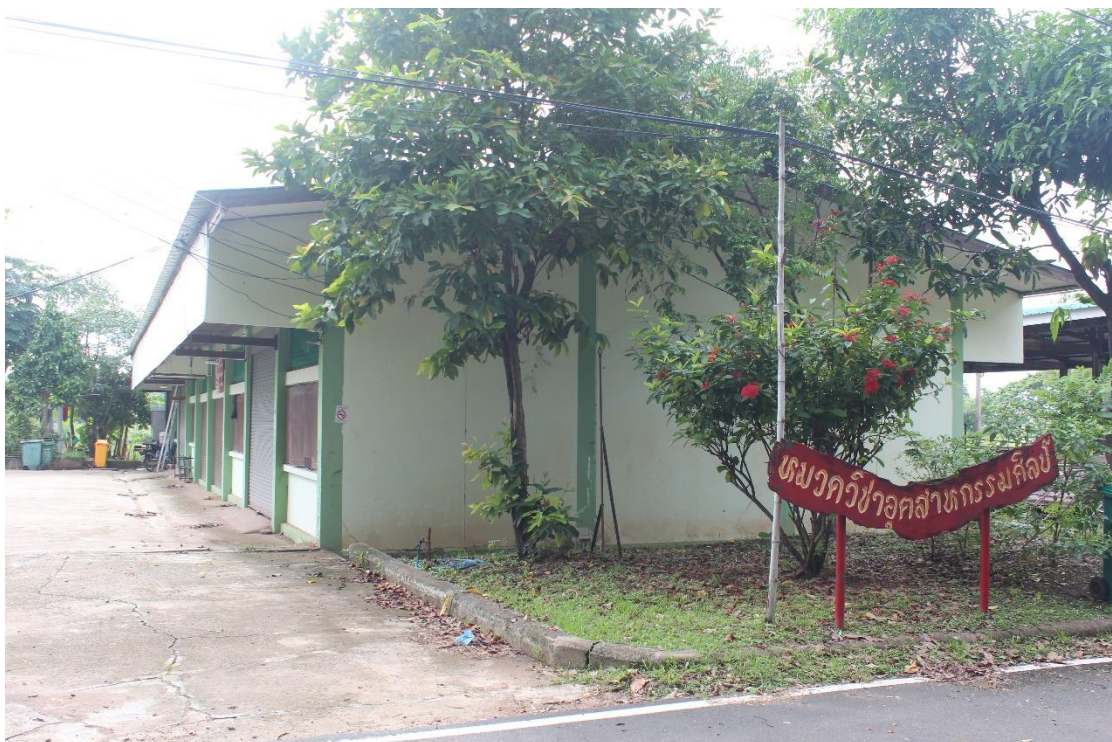
อาคารโรงฝึกงาน
